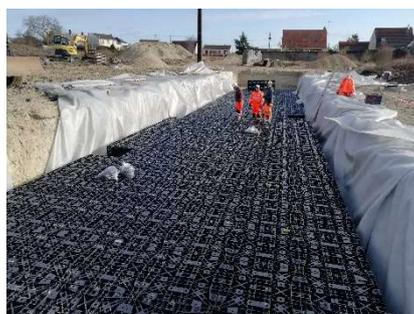
Visite de chantier lotissement à CHAINGY : installation d'un bassin de rétention enterré pour récupérer les eaux pluviales
