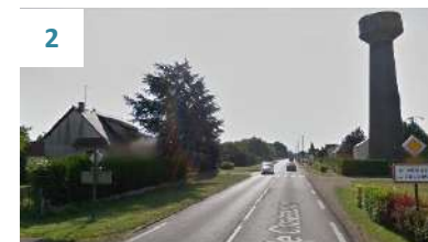
2 L'entrée de ville Ouest de St-Péravy-la-Colombe, marquée par des aménagements paysagers et le château d'eau
