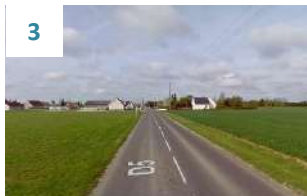
L'entrée de ville Est de Sougy, rupture nette entre les espaces urbanisés et agricoles
