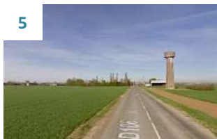
L'entrée de ville Est de Bucy-le-Roi, le château d'eau comme marqueur de l'entrée de ville, haie haute formant une transition qualitative avec l'espace agricole
