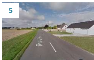
5 L'entrée de ville Est de Saint-Sigismond, urbanisation linéaire face aux espaces agricoles
