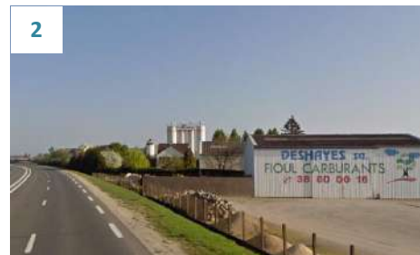
2 L'entrée de ville Sud d'Artenay, activités et caractère routier de la déviation
