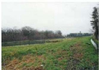
Station par lagunage de Jouy-le-Potier
